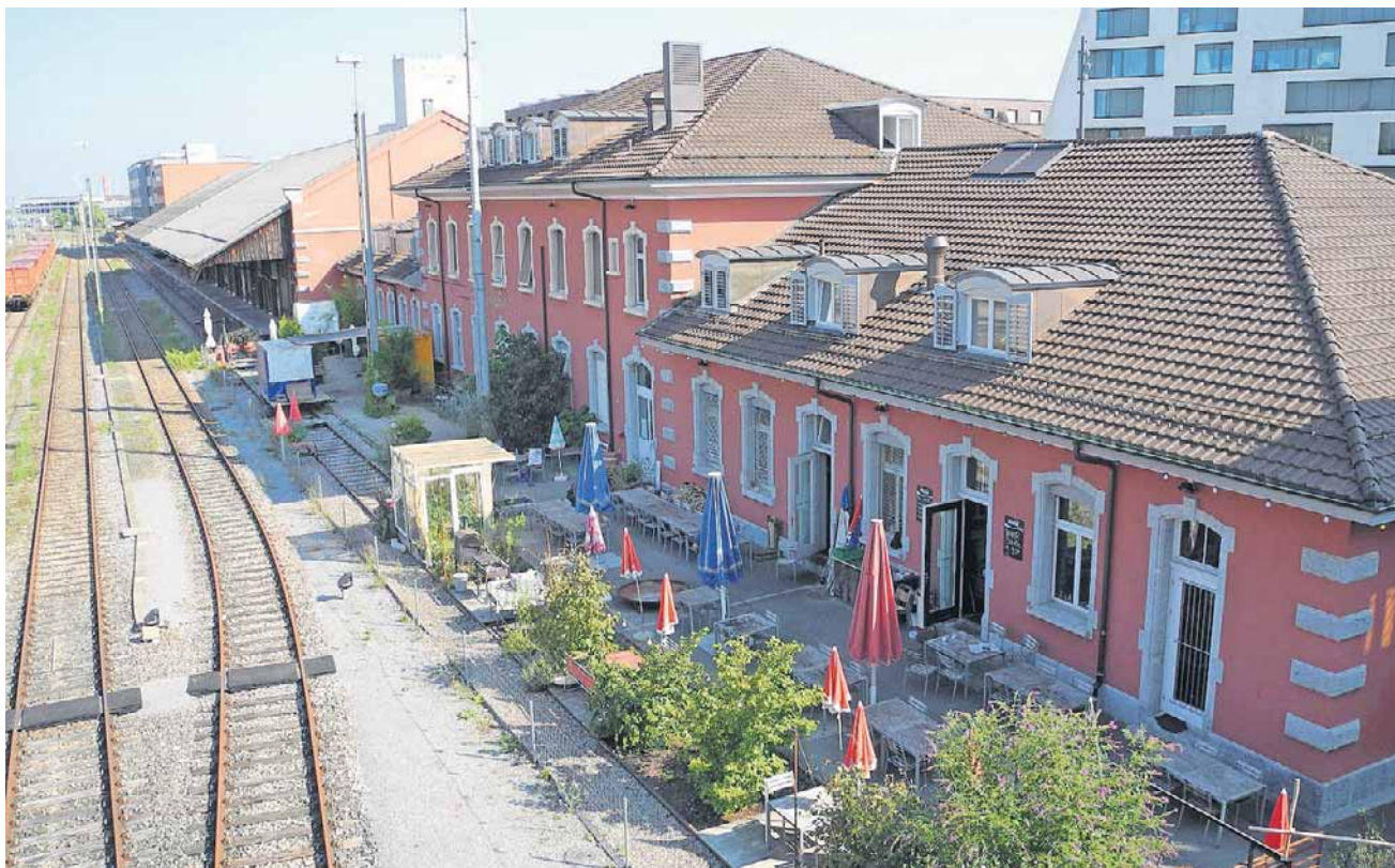
Der Blick vom Bahnübergang auf die Hinterseite. Die urbane Oase des Stellwerks bietet Restaurant und Bar.
